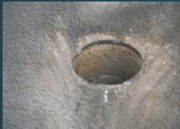
1. Fertiggestellte Kernbohrung in Flachdach
