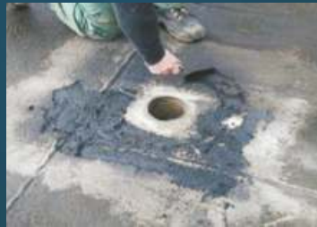
2. Die Fläche um die Kernbohrung mit Bitumendichtmasse bestreichen.
