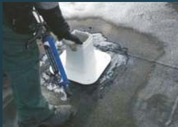
4. Dachdurchführung aufsetzen und andrücken.
