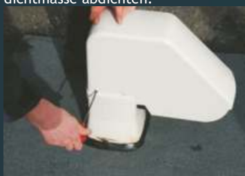
10. Haube aufsetzen und verschrauben.
