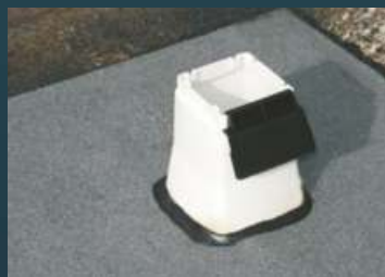
8. Rohrführung aufsetzen.
