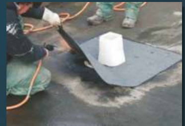
6. Dachpappe im Flämmverfahren mit Untergrund verbinden.
