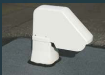
11. Fertig installierte Dachdurchführung.
