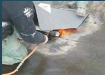
5. Dachpappe mit Ausschnitt über die Dachdurchführung legen.
